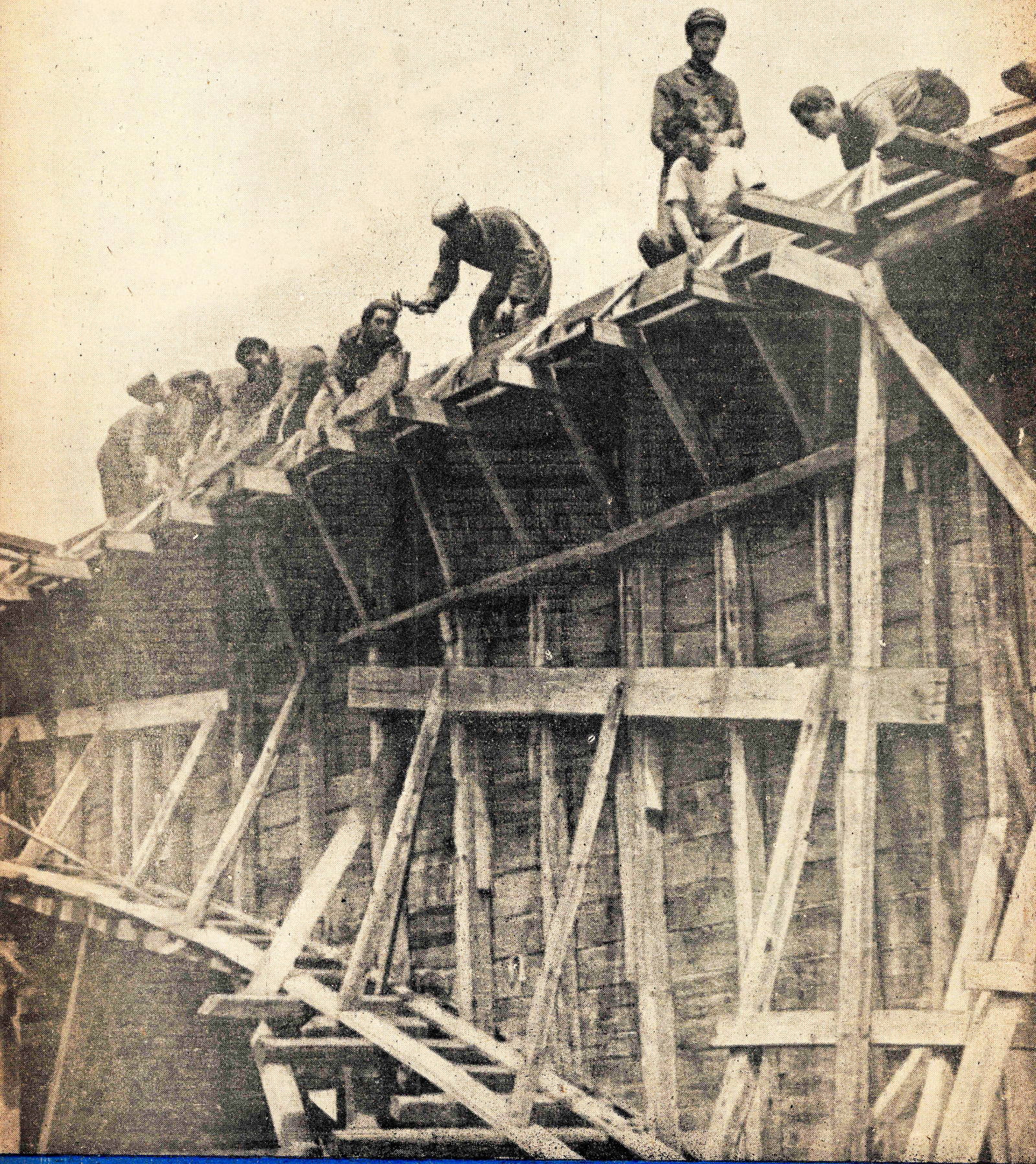
БРИГАДИРИ СТРОЯТ МОСТ ПРИ ВЪРЕИЦА
